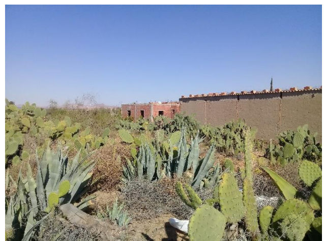
Photos 2: Constructions au niveau de la piste au PK20+250 de la RR83
